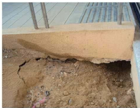
液状化現象か、建物の地下構造物がむき出し状態
