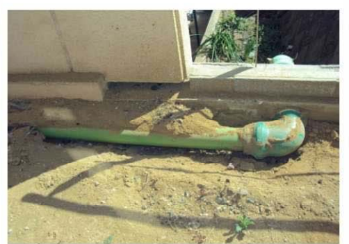
液状化現象か、建物の地下構造物がむき出し状態
