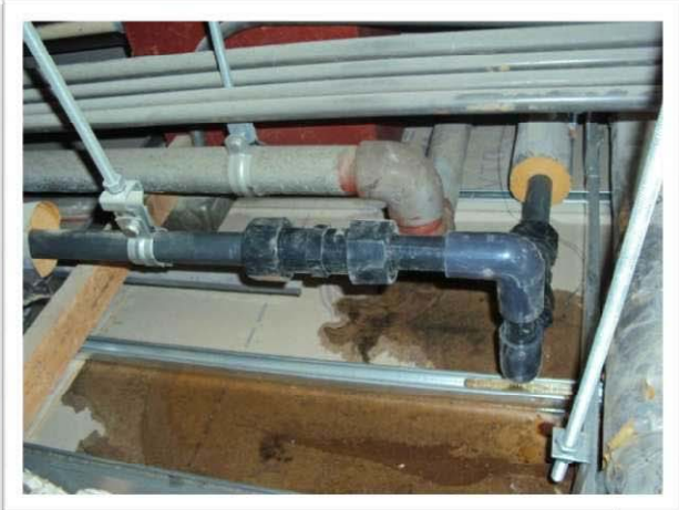
温泉配管の応急修繕状況！
